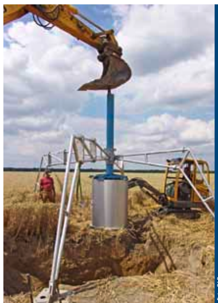
Ein Lysimeter wird mit Erdboden gefüllt
