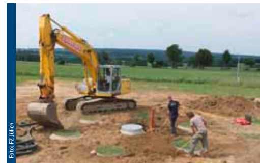
Ringförmig um einen zentralen Mess- und Service-schacht sind jeweils sechs weitere in den Boden eingelassene Lysimeterpositionen angeordnet (o.)
