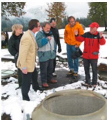
Besichtigung des Rohbaus der Lysimeter-Anlage in Graswang
