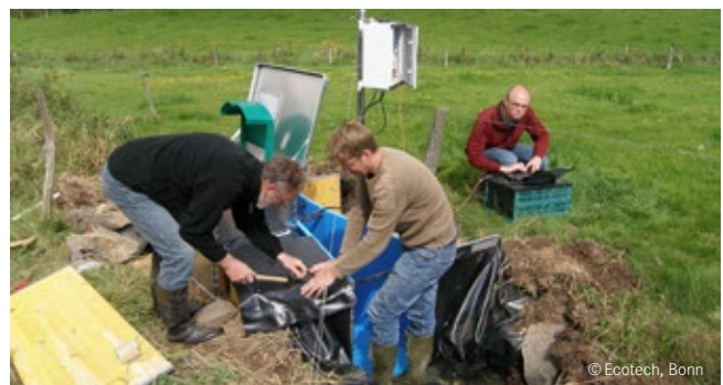
Aufbau der hydrologischen Messstation Rollesbroich
