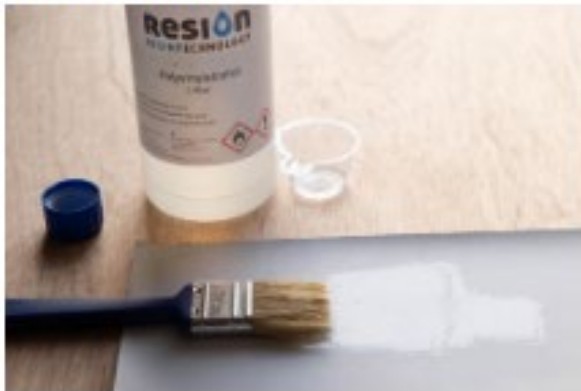
(d) Application of the first layer of PVA
